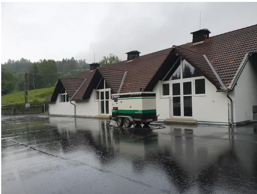
Foto: ČOV Kašperské Hory – napájení ze záložního zdroje v době odstávky EE
