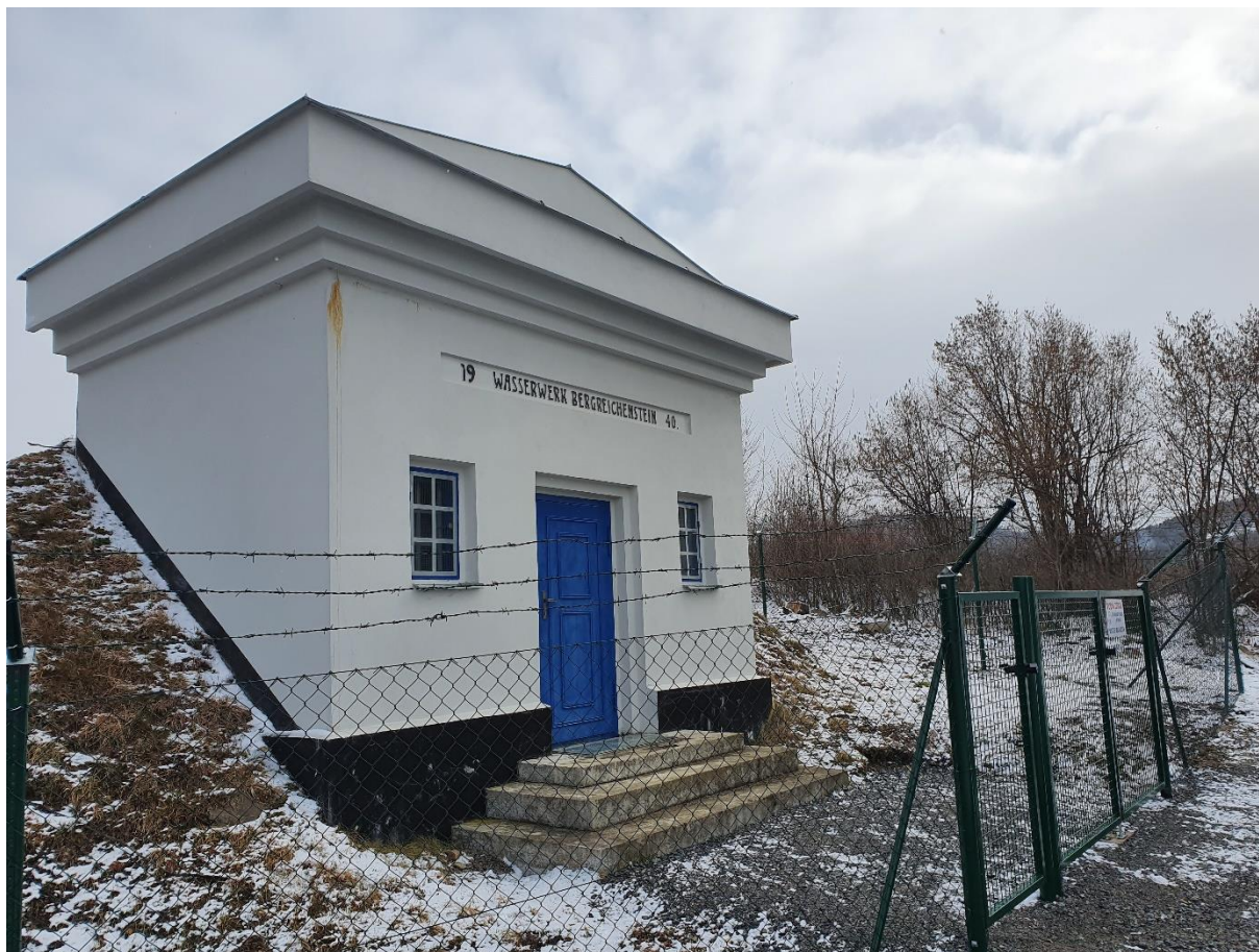
Foto: Vodárna nad školou
