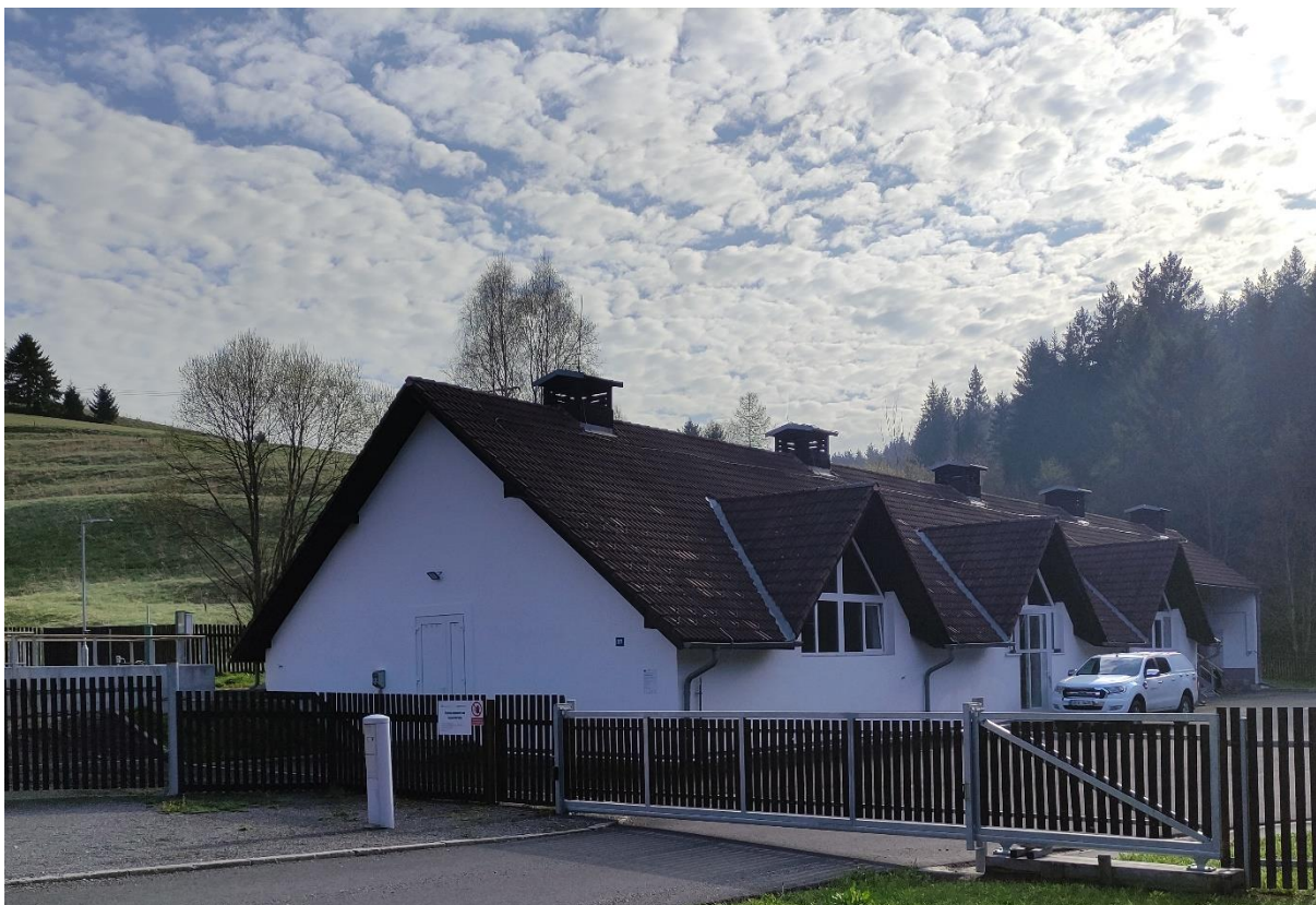
Obr. č.9: ČOV Kašperské Hory
