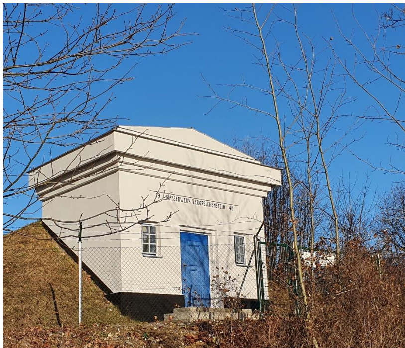
Obr. č.6: Vodárna nad školou
