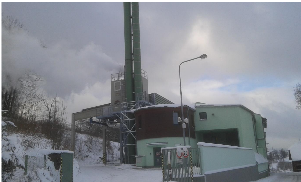
Obr. č. 1: Centrální výtopna na biomasu
