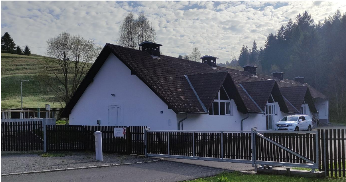
Obr. č.6: ČOV Kašperské Hory
