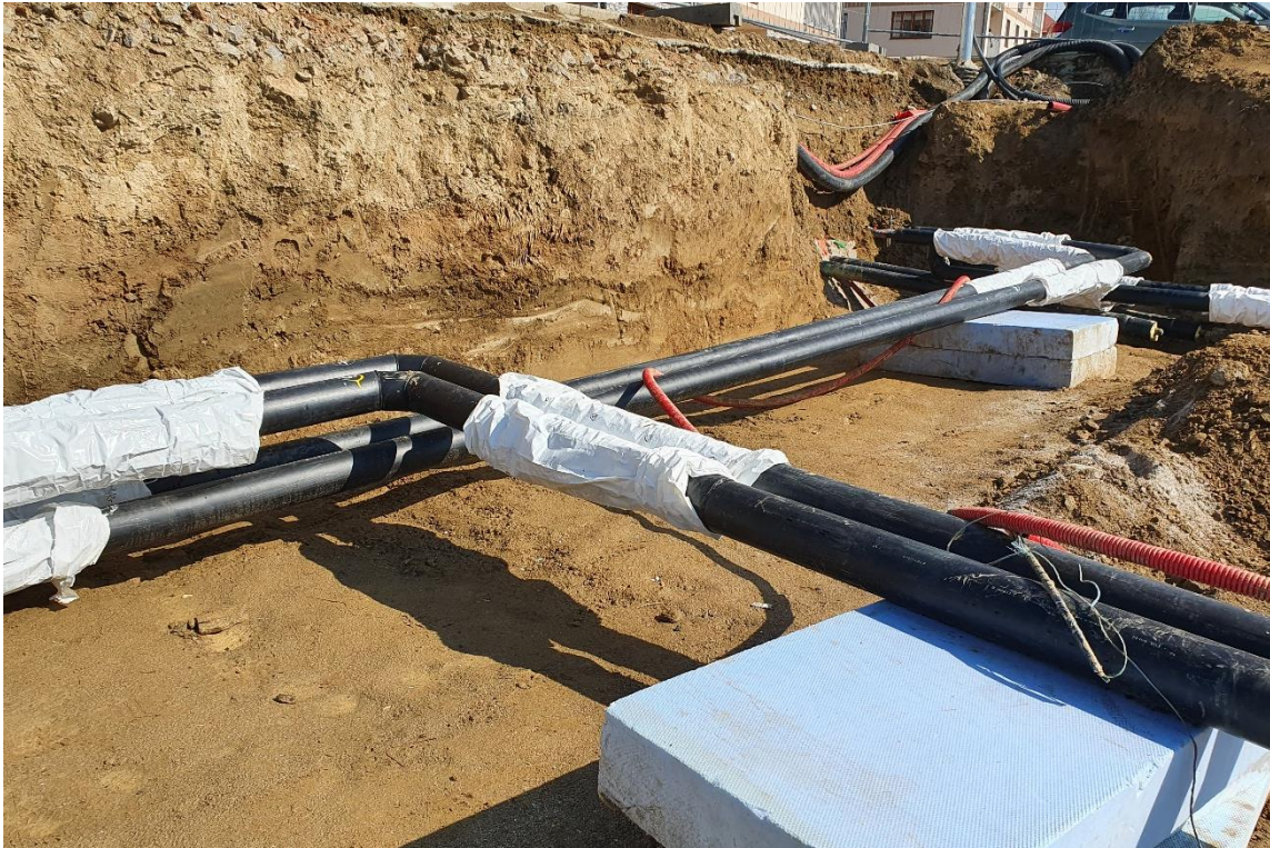
Obr. č.3; III. etapa montáže teplovodu pro lokalitu Besední/Nová (nově Lesní ul.)
