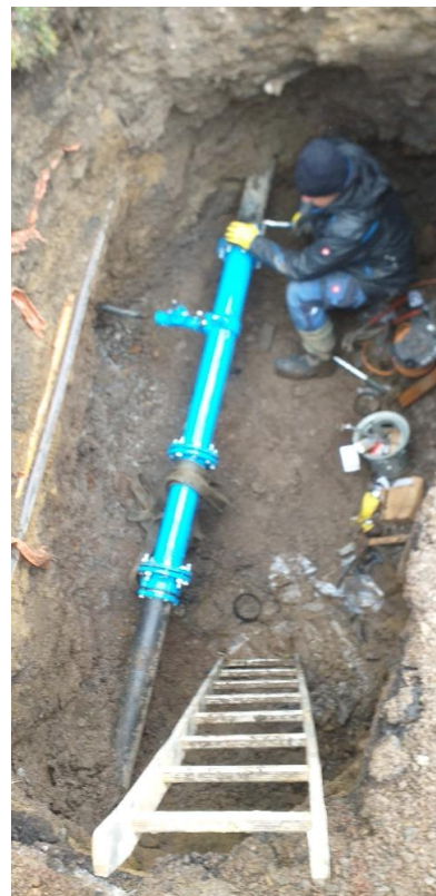
Obr. č. 5: Oprava poruchy vodovodního řadu
