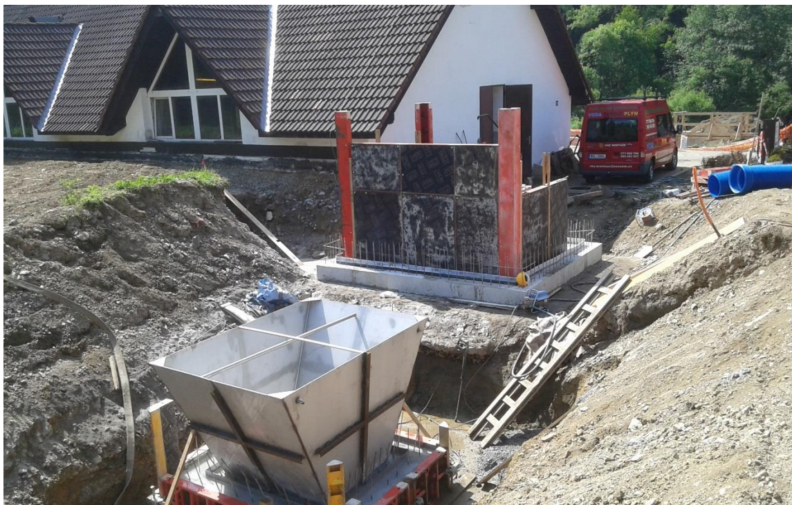
Foto: Intenzifikace ČOV – v popředí realizace lapáku štěrku a odlehčovací komory
