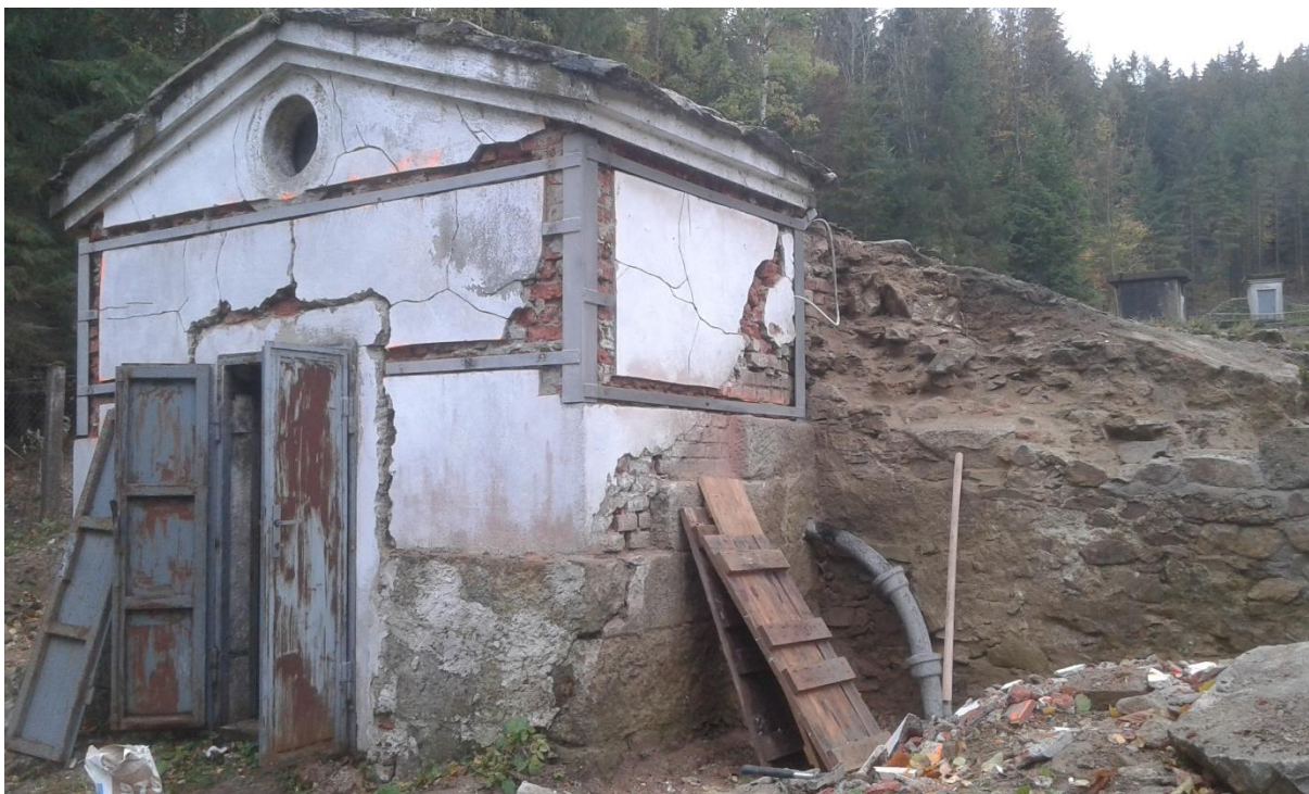
Foto: obnova prameniště Starý Žďánov - vodárna
