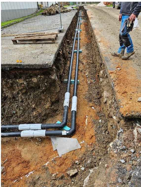
Obr. č.7; realizace teplovodní přípojky pro BD v České ulici
