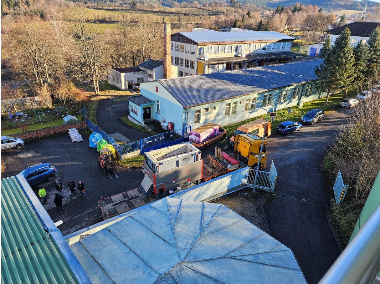
Obr. č. 1: Centrální výtopna na biomasu – doprava části nového kotle.
