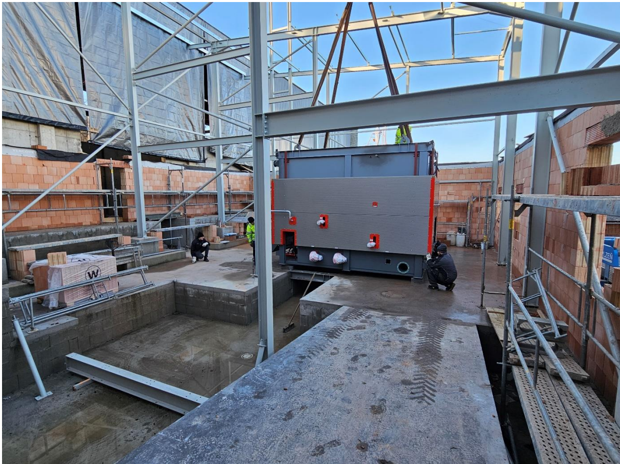
Obr.č.6: Doprava spalovací komory nového kotle (10.12.2025)
