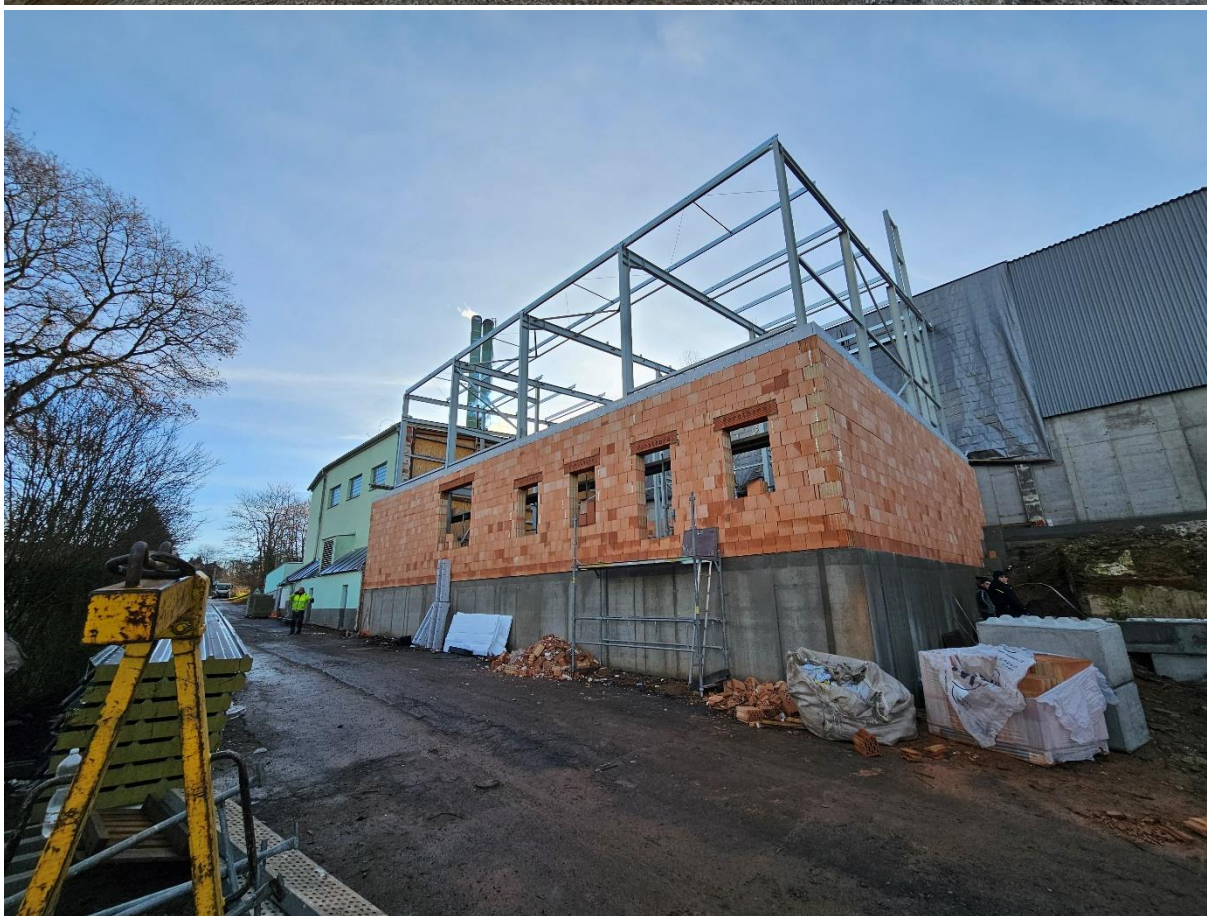
Obr.č.4,5: Demolice administrativní budovy pily – stav leden 2025, výstavba – stav prosinec 2025
