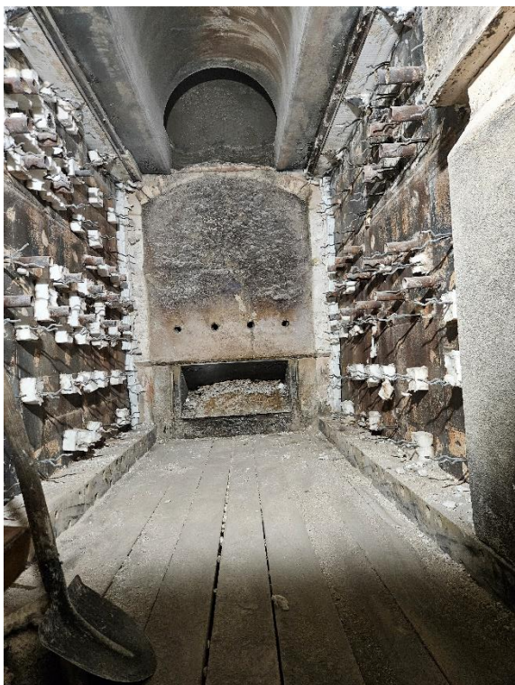
Obr. č.2,3: Oprava vyzdívky kotle K2
