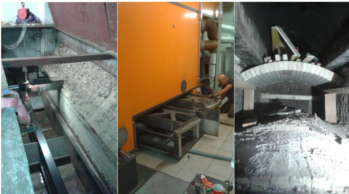
Fota: 1. oprava hydraulického podavače; 2. demontáž roštů u K1 a K2; 3. výstavba nové klenby u K2
