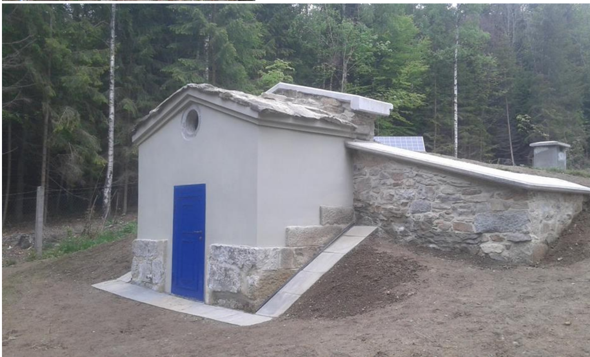
Foto: obnova prameniště Starý Ždánov – vodárna v době rekonstrukce a po rekonstrukci v roce 2019
