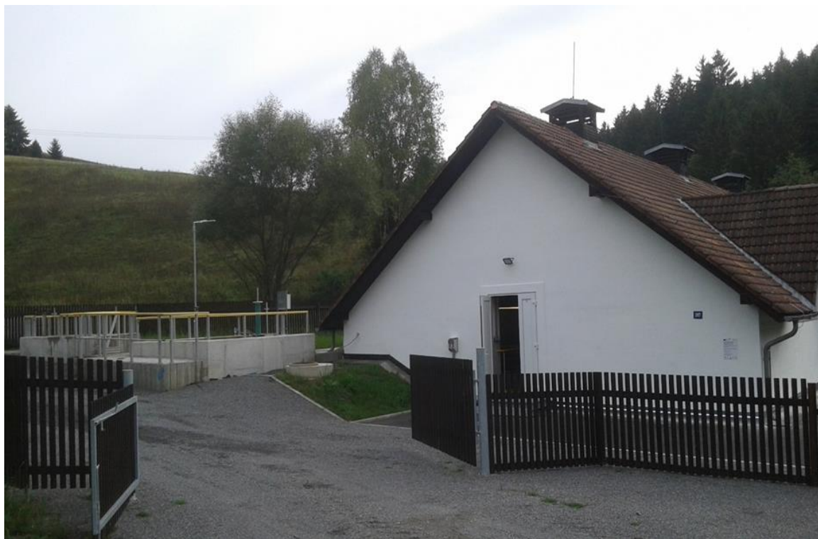
Foto: Intenzifikace ČOV – vlevo realizace lapáku štěrku a odlehčovací komory, vpravo budova ČOV v přední části s novým oplocením
