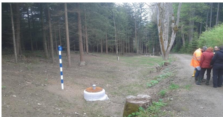
Foto: obnova prameniště Starý Ždánov
