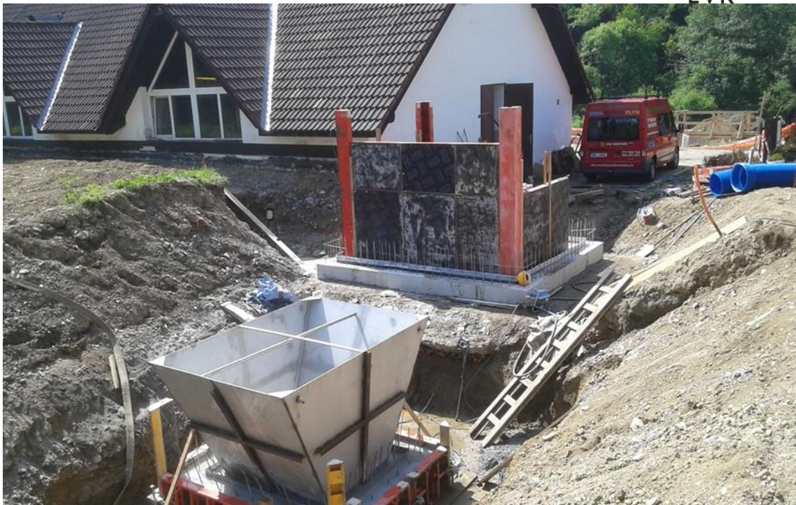
Foto č 3: Intenzifikace ČOV – v popředí realizace lapáku štěrku a odlehčovací komory
