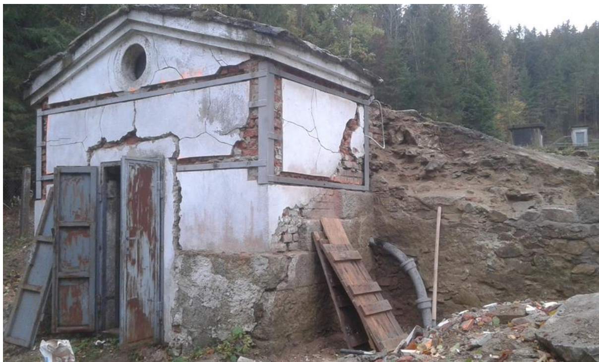
Foto č.2 : Obnova prameniště Starý Ždánov - vodárna
