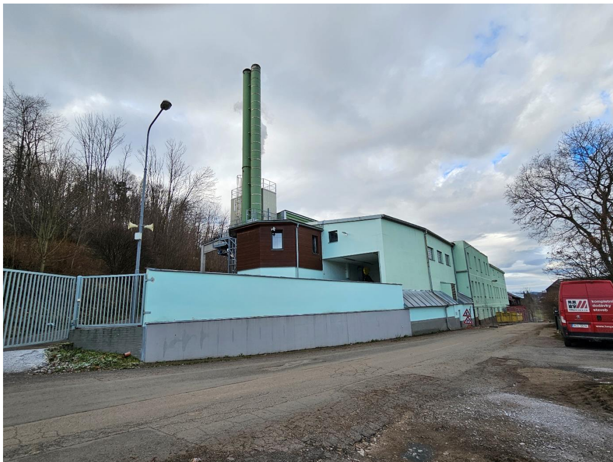
Obr. č. 1: Centrální výtopna na biomasu.
