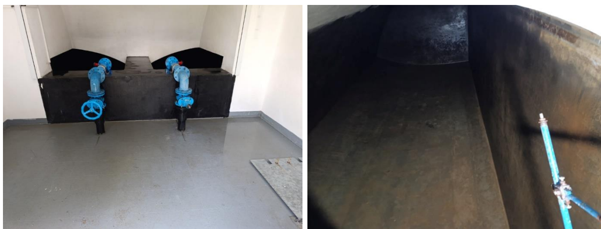
Obr. č.11,12: Vodojem Nad školou po kompletním vyčištění
