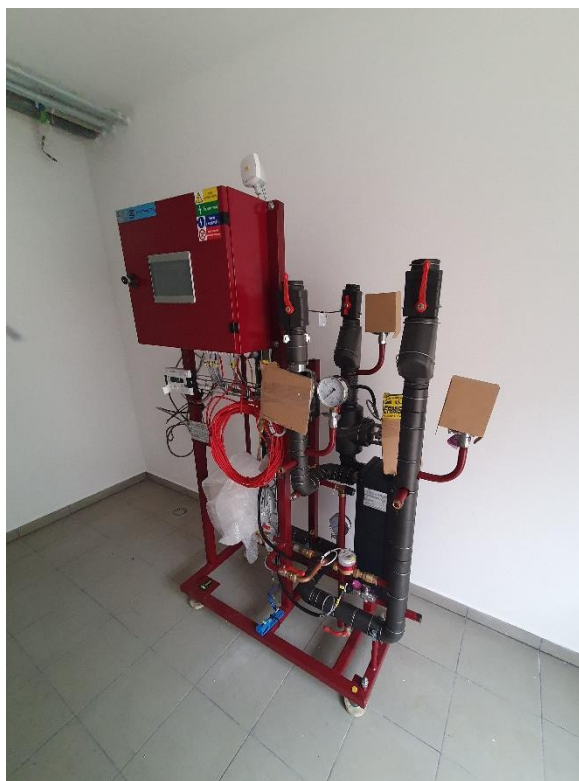
Obr. č.9,10; Instalace rozdělovače k nové OPS pro objekt Bílá růže a OPS pro BD v Besední
