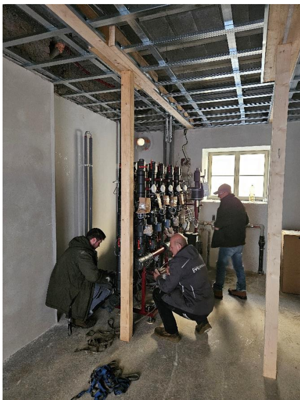
Obr. č.9,10; Instalace rozdělovače k nové OPS pro objekt Bílá růže a OPS pro BD v Besední
