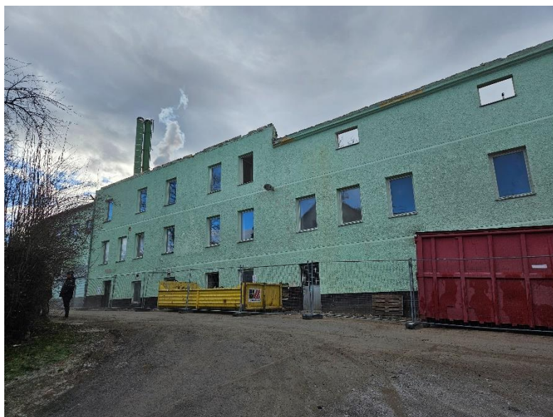
Obr.č.8: Demolice administrativní budovy (na fotografii již bez střechy)
