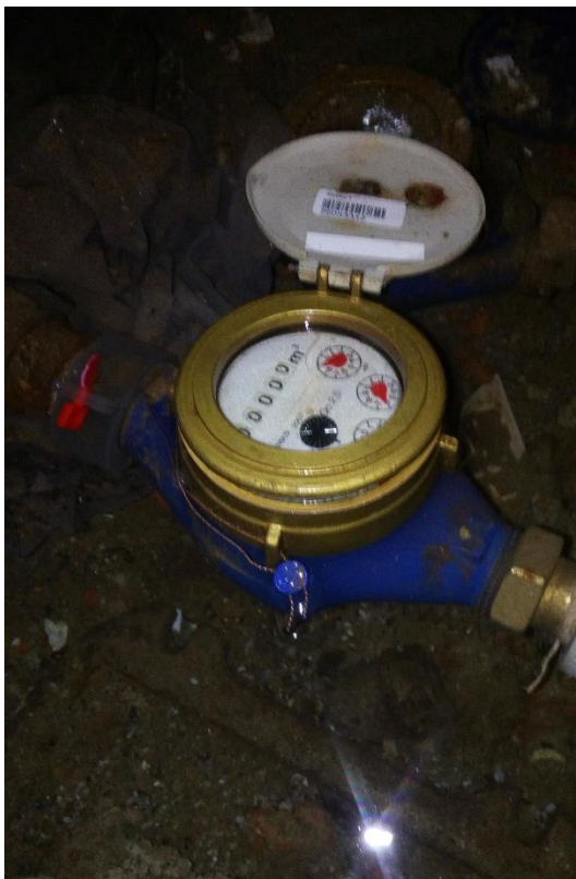
Obr. č. 13,14: Stávající vodoměr a dálkově odečitatelný vodoměr iPERL
