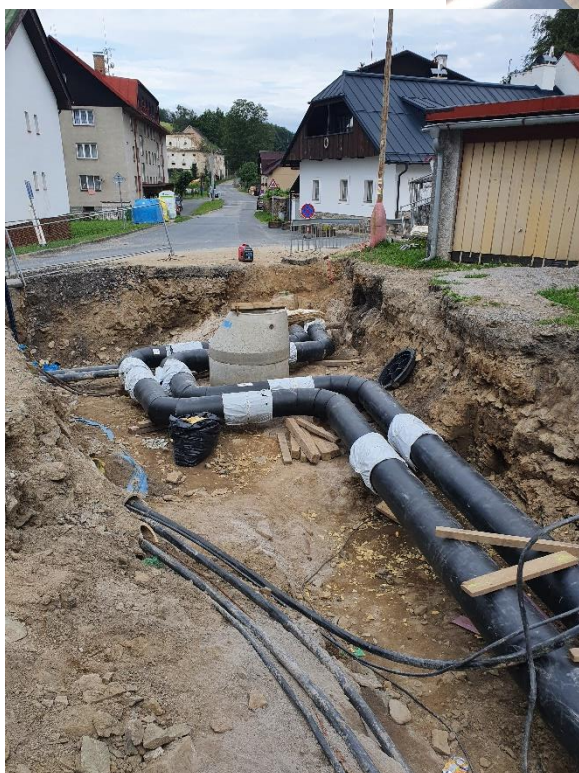
Obr.č.7: Pokládka teplovodního potrubí s kompenzátorem
