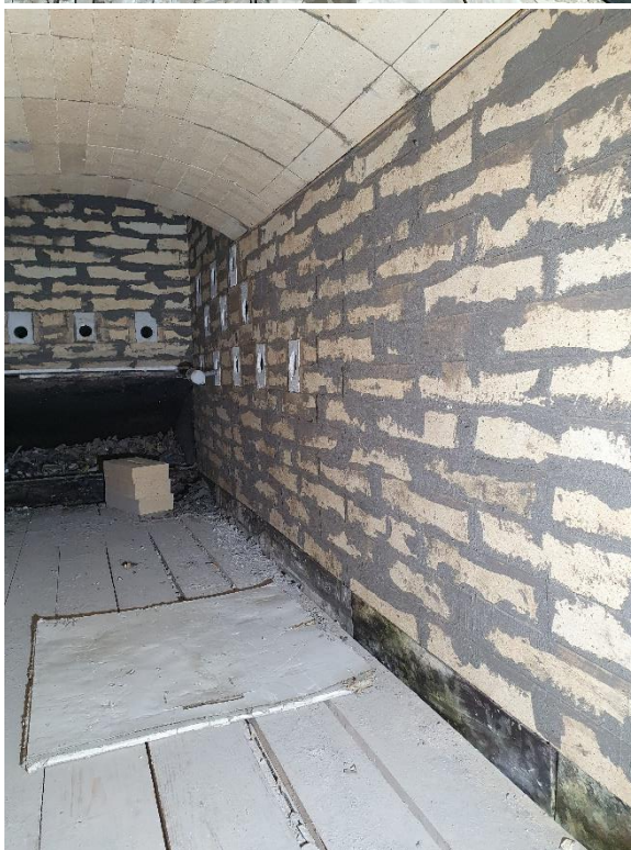
Obr. č.2,3,4,5: Oprava vyzdívky kotel K1
