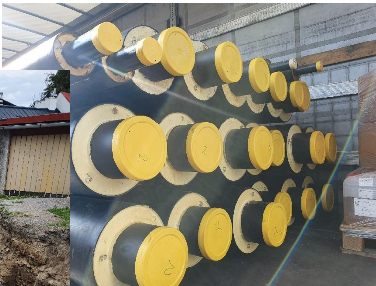
Obr.č.6: Dodání předizolovaného potrubí na stavbu
